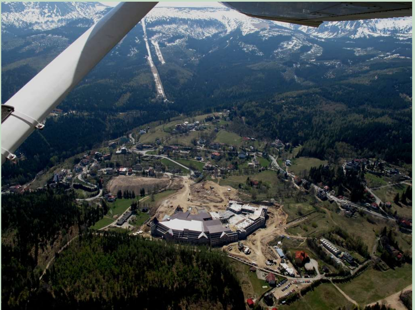
Karpacz: budowa hotelu i widok na Kope
